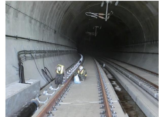
新幹線の安全運行や、沿線環境の保護にとって、走行地域から発生する水(地下水、雪解け水など)の処理は大きな課題です。これらの水は専用設備で集水した後、処理施設まで運ぶ必要がありますが、当社はその送水管を固定するための金具を製造しました。線路脇の様々な構造物に影響を及ぼさない形状、勾配が一定でない中でもスムーズに送水するための工夫、送水管自身にダメージを与えない構造などを開発部門だけでなく製造部門のアイデアも活かし、難しい問題を解決しました。
