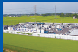
杉戸機材センター
